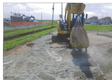
セメントによる地盤改良
