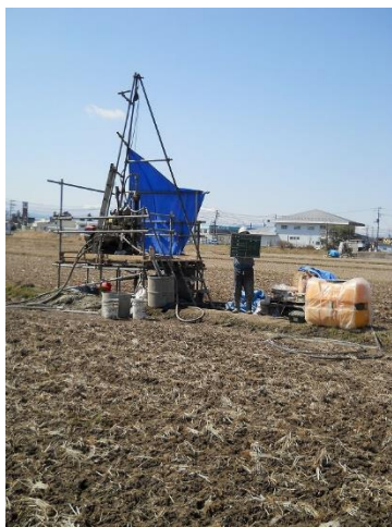
ボーリング調査の状況
