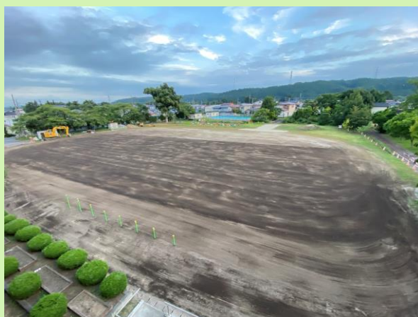
8/22 校庭整地工事
