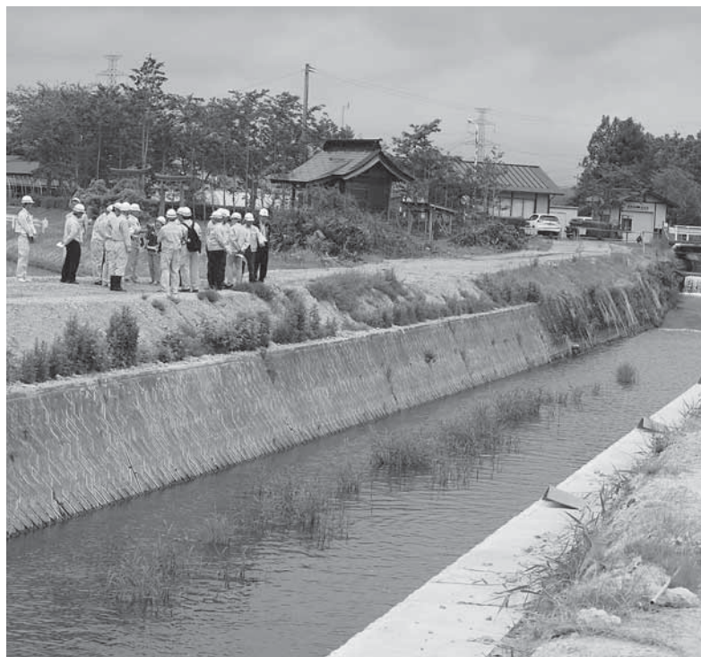
復旧工事は順調に進んでいます
