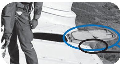
ナセル（発電機などを納めているスペース）
