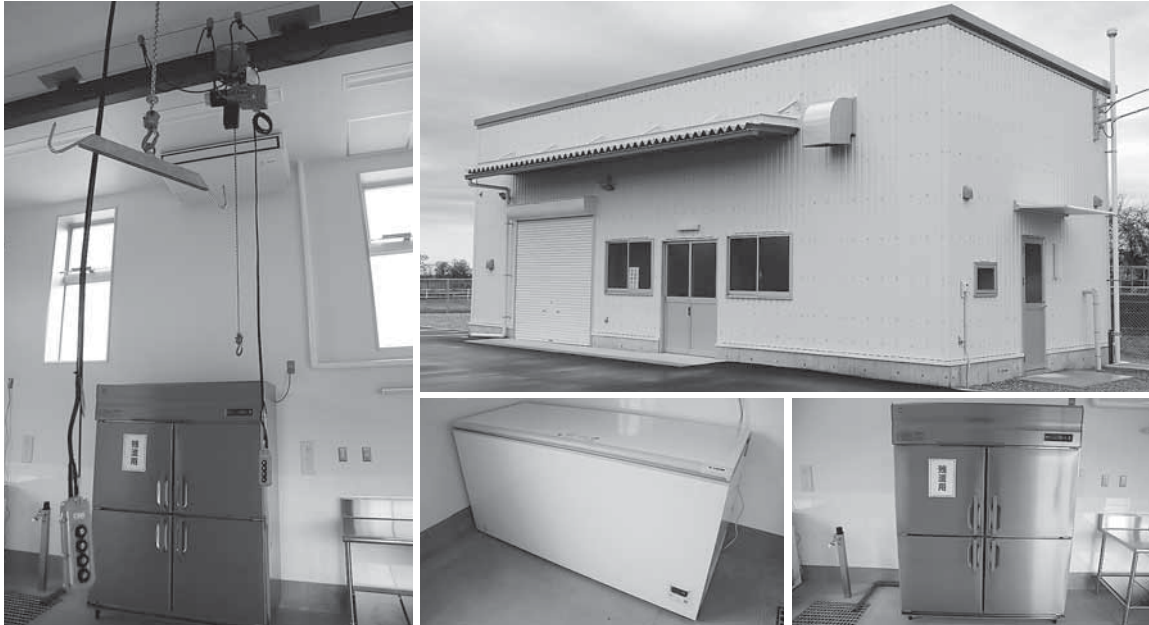
外観（右上）、残渣用冷凍庫（右下）、解体前保存用冷凍庫（下）、クレーン（左）
