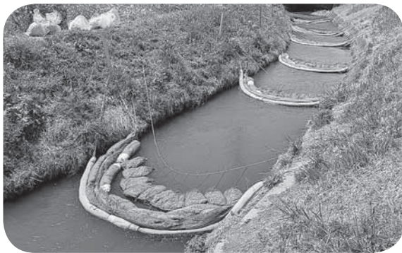
オイルフェンスで下流域への油流出防止
