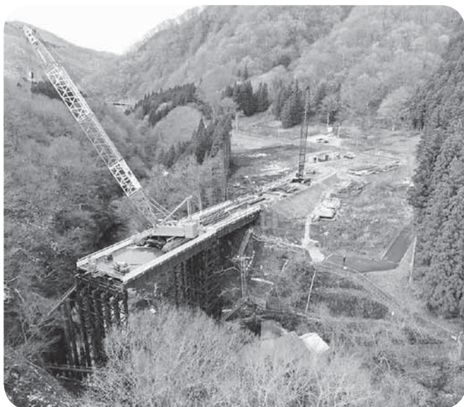
工事用道路として仮設橋の設置工事を実施中 写真：鳴瀬川総合開発工事事務所から提供
