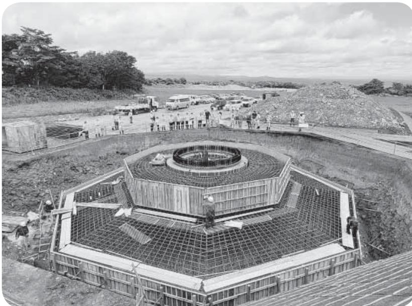
基礎の鉄筋や、コンクリートを流し込む枠を組み立て中
