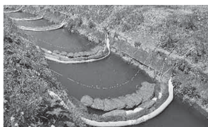
①河川にオイルフェンスを設置
