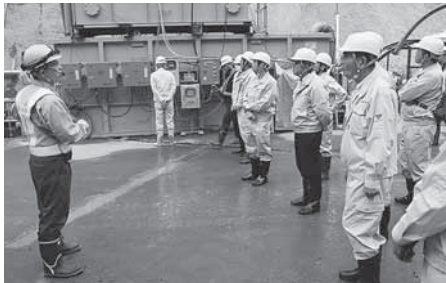
現場担当者から工事の進捗状況の説明
