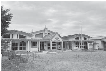
有効活用が期待される公共施設
