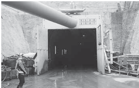
工事が進む仮排水トンネル
