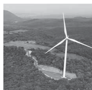
整備された道路や法面（JRE風力発電）
