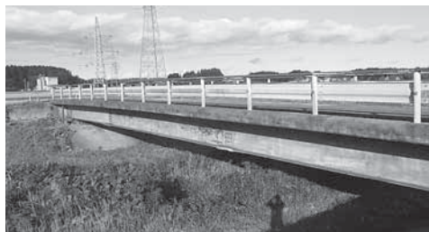
令和10年度まで全34橋を修繕する計画であり、本工事26橋目となる
