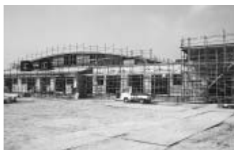
建設中の中新田統合保育所
