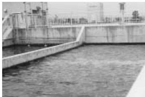
中新田浄化センター内の処理施設
