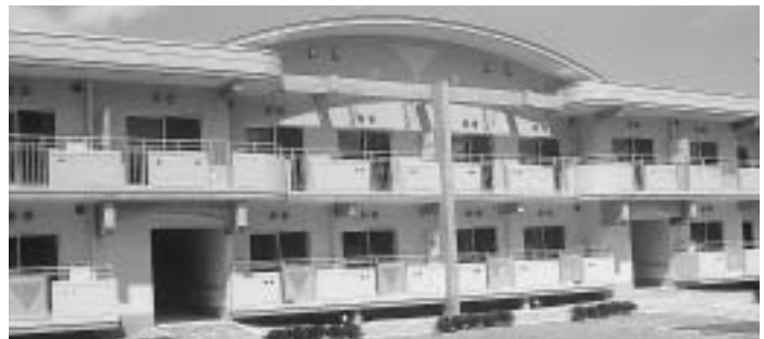
改築になった加美町宮北原 住宅(北区)
