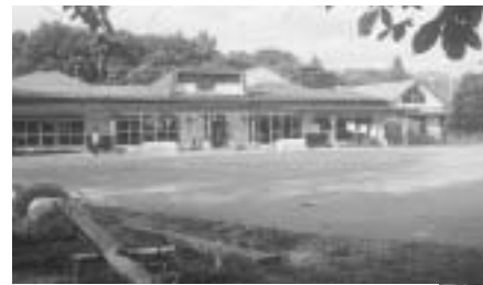
今年度中に解体される 広原・鳴瀬保育所
