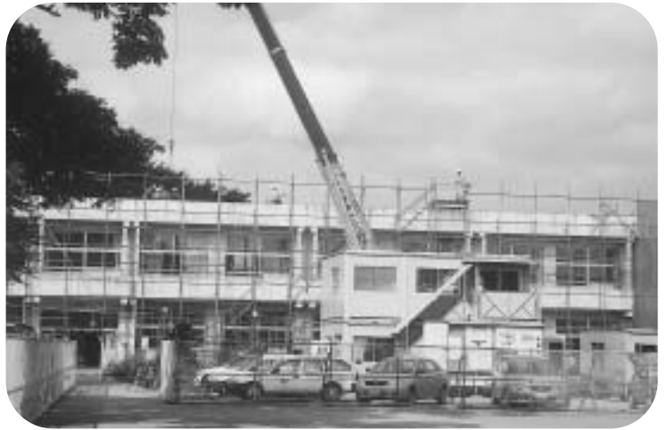
大規模改造工事が進む宮崎小学校
