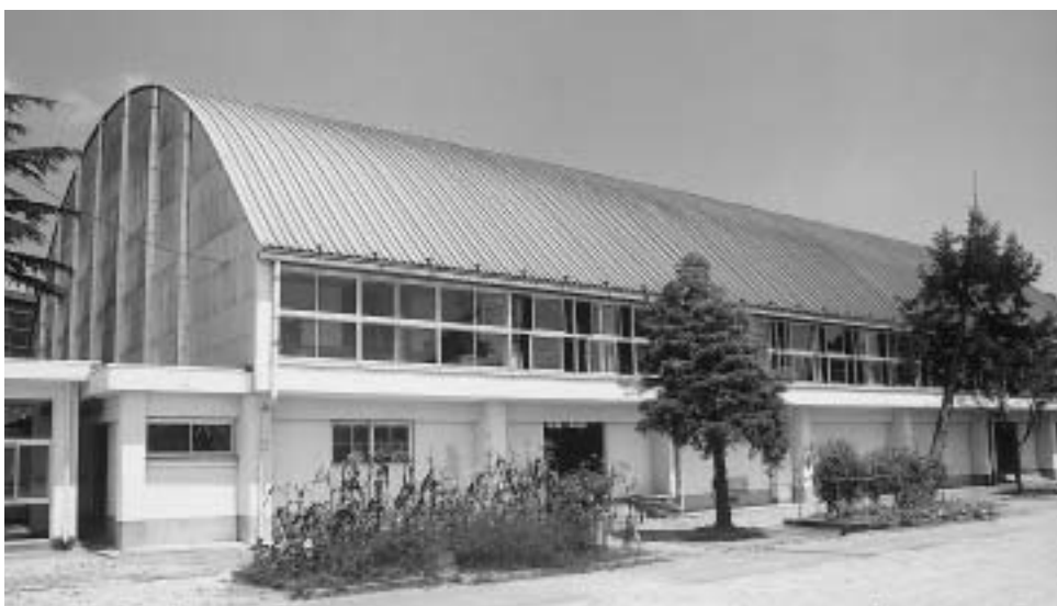
大規模改修工事が行われる中新田中学校体育館
