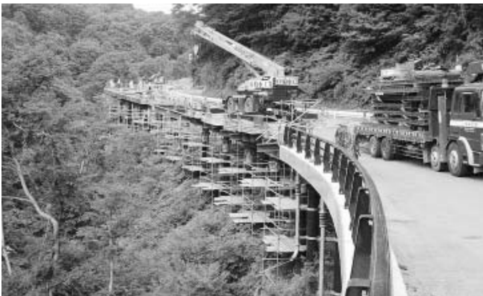
工事が進められている国道347号筒砂子地区
