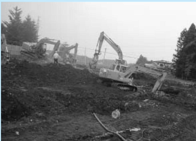
広原小学校のプール建設に向けて
