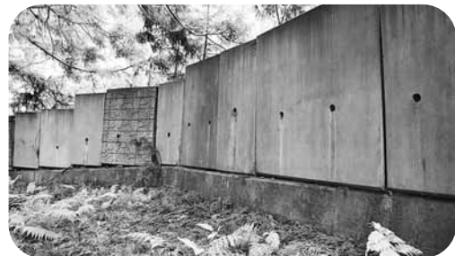
孫沢道路の擁壁（令和2年4月21日現在）
