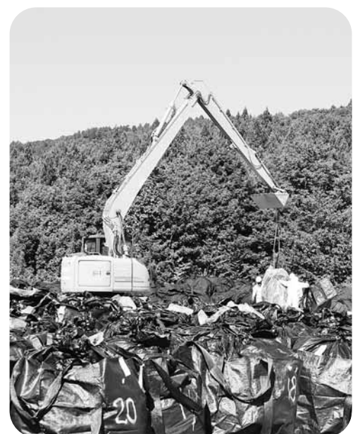
旧田代放牧場のフレコンバッグ詰め替え作業
