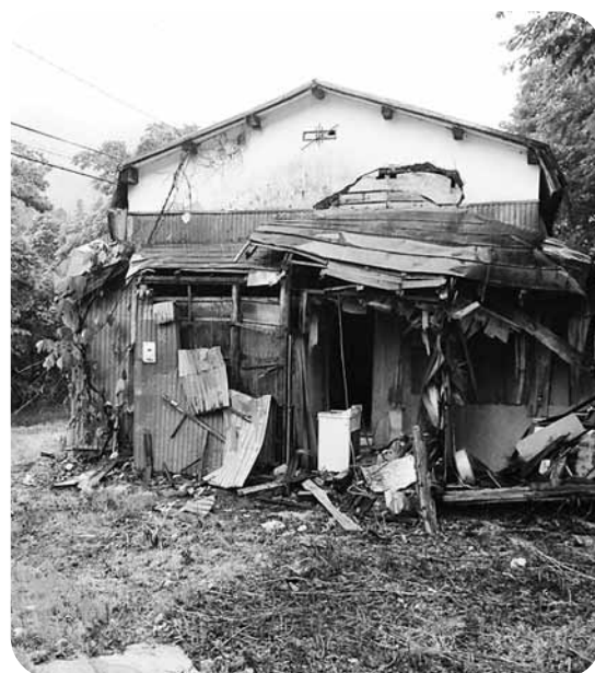
危険な空き家の改善が望まれる
