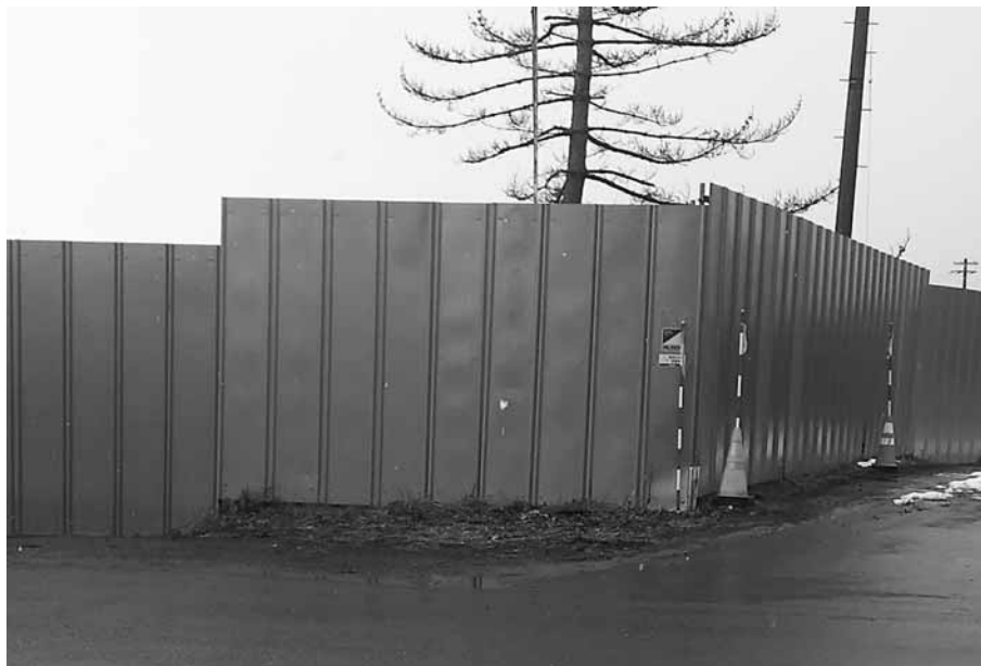
孫沢字東沢・公衆用道路を含む土地を囲う塀
