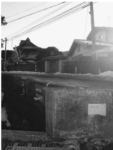
拡張改良工事を実施する寺前橋
