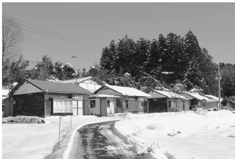
鳥屋ヶ崎町営住宅
