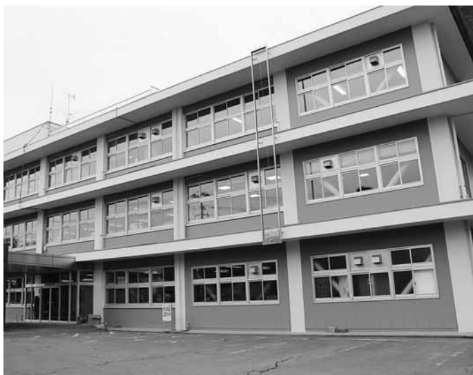
耐震補強後の本庁舎
