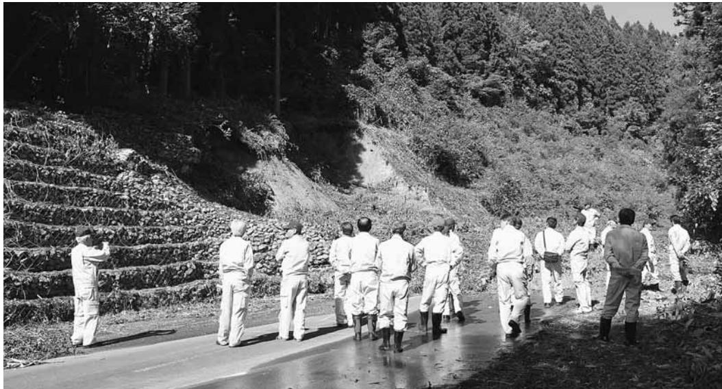
大規模崩落が起きた町道長沼線
