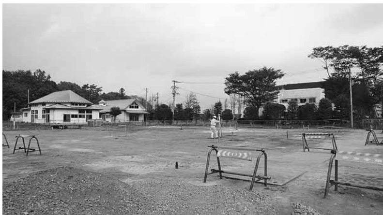
着手された広原地区定住促進宅地造成工事
