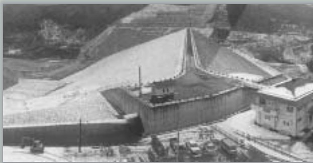
完成間近の二ツ石ダム
