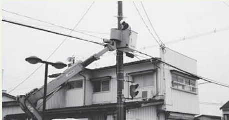
地震発生から4日目、電気復旧のきざし(3/15)
