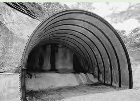
▲トンネル入口の様子 (長さ439m)
