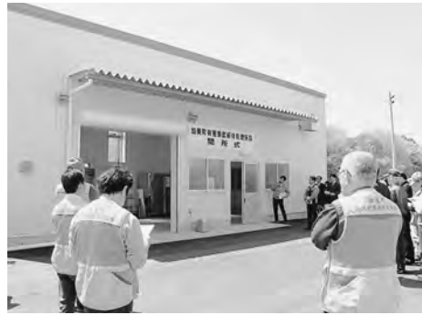
▲鉄骨平屋建て、約75㎡の処理施設
